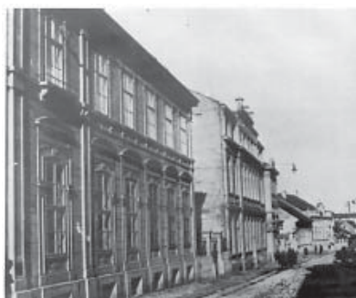
Sl. 64. Zgrada u Brankovoj 15.
