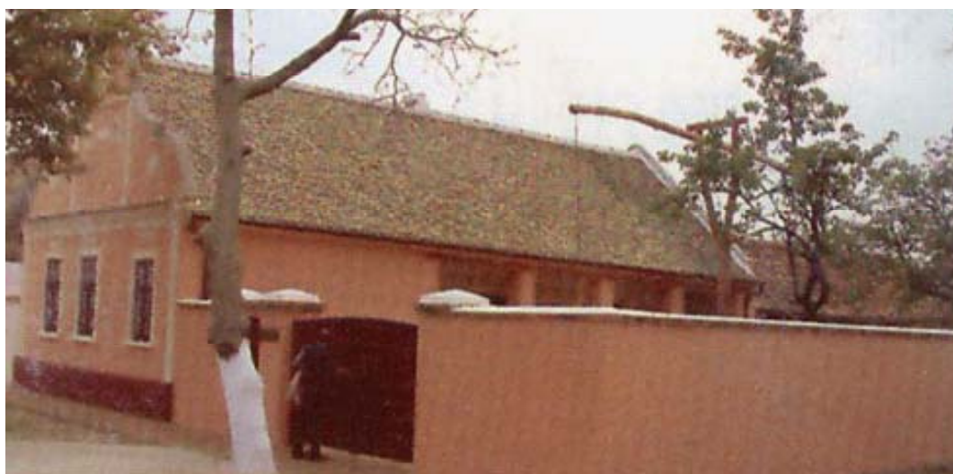
Renovirana Pupinova kuća 2004.
